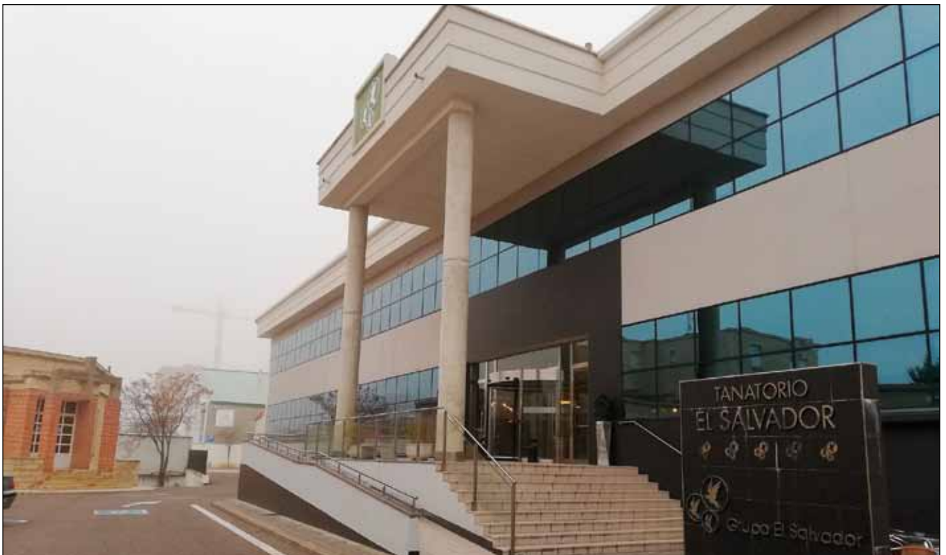
Instalaciones en Valladolid del tanatorio investigado en el caso Ignis
